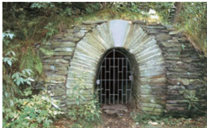
Stollenmundloch im Naturschutzgebiet „Schwarzwassertal“
